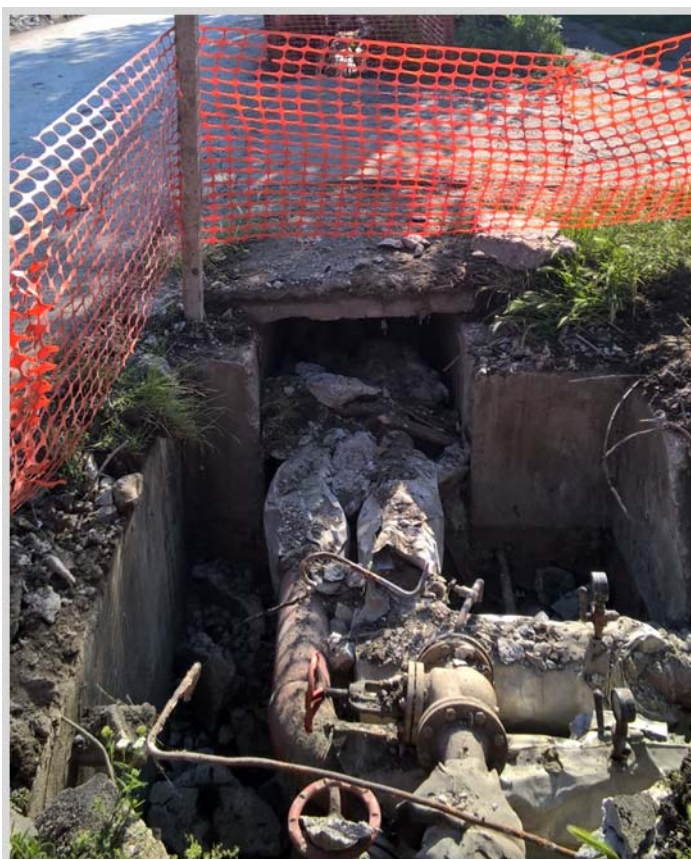
Stávající trasa včetně stavu šachty
